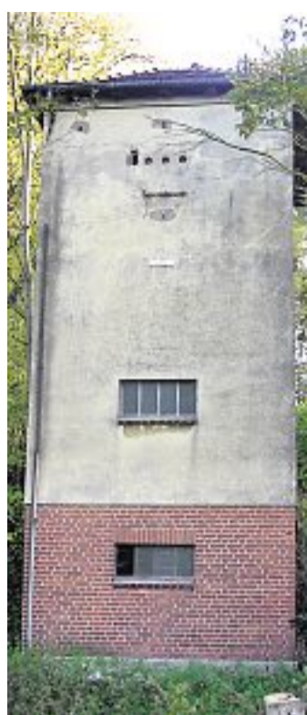
Offen: das Trafohäuschen.
